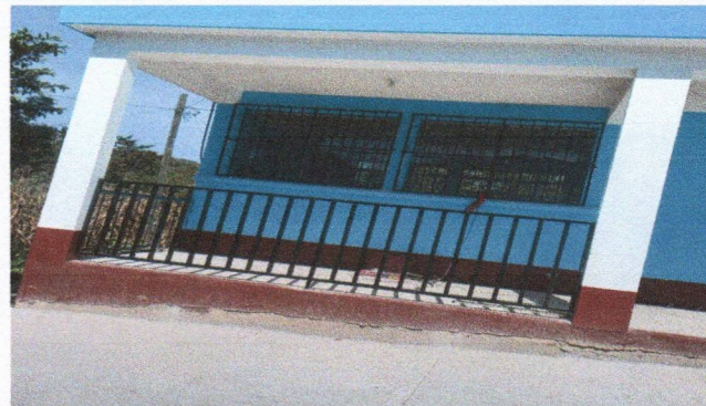
Foto 2: Sustitución de barandas de metal.
