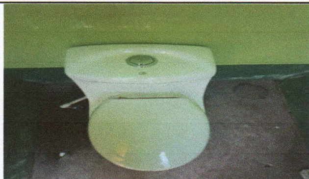
Foto 5: Sustitución de inodoros
