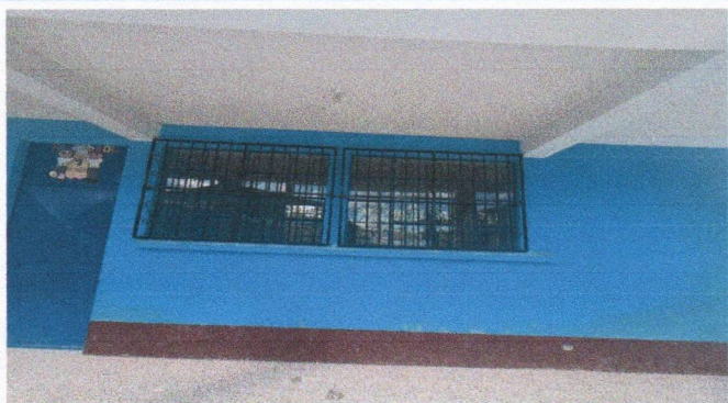
Foto1: Mejoramiento de balcones de metal.
