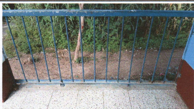
Foto 3: Mejoramiento de barandas de metal.
