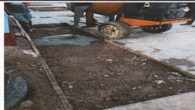
Foto 4: Reparación de planchas de concreto en piso
