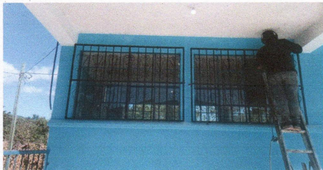
Foto1: Mejoramiento de balcones de metal.
