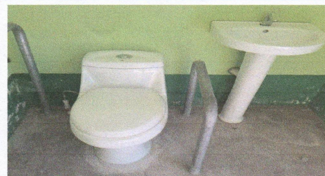
Foto 5: Sustitución de inodoros
