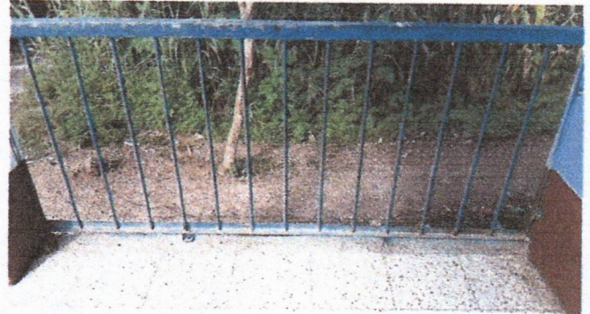
Foto 2: Sustitución de barandas de metal.
