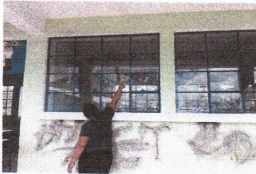
Foto 1: Mejoramiento de balcones de metal.
