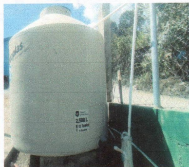
Foto 7: Sustitución de depósito de agua de 2500 LT: Depósito de agua instalado a donde corresponde, para el abastecimiento de agua, extraído de los pozos. Para mejoras del centro educativo.
