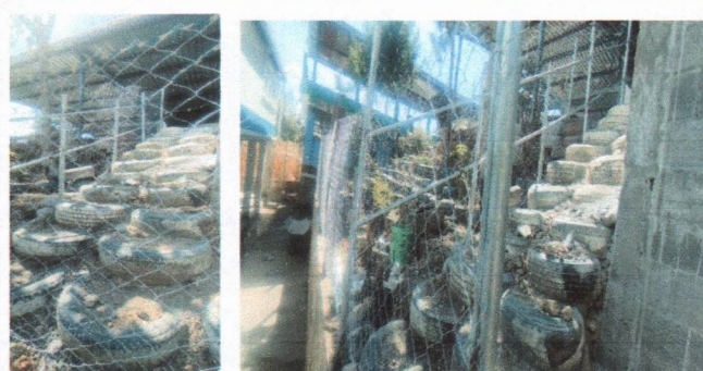
Foto 4: Sustitución de baranda de metal: Se han colocado barandas para la seguridad de los estudiantes y así poder tener mejorar las condiciones y ambientes del centro educativo
