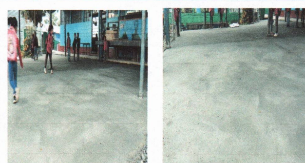
Foto 6: Reparación de plancha de concreto a patio: plancha de concreto finalizada con éxito, como se puede evidenciar la alegría de los estudiantes sobre el concreto.
