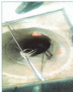
Foto 8: Sustitución de bomba de agua: Bombas de agua sumergibles, ya instaladas donde corresponde, para la succión de agua a depósitos externos.
