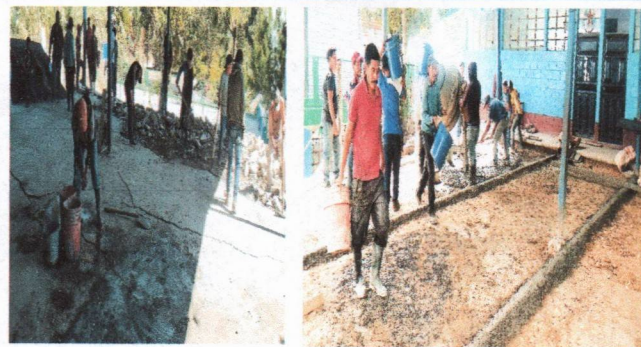
Foto 6: Reparación de plancha de concreto a patio: en este proceso se evidencia la demolición de la plancha de concreto, como tambien la colocación de la nueva torta de cemento.
