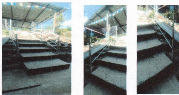
Foto 3: Mantenimiento a baranda de metal: Avance de la colocación del pasamanos, para seguridad de los estudiantes
