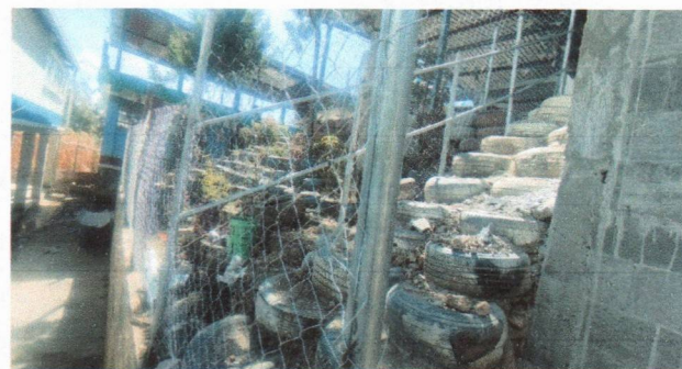
Foto 4: Sustitución de baranda de metal: Se han colocado barandas para la seguridad de los estudiantes del establecimiento
