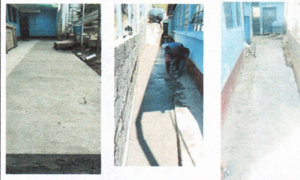
Foto 2: Reparación de cunetas de concreto: El avance de cada una de los espacios a intervenir; con trabajo y dedicación.
