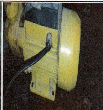
Foto 8: Sustitución de bomba de agua: (Por deterioro y por el tiempo de uso de las bombas, se promueve la sustitución por bombas de agua sumergibles)
