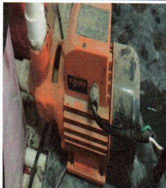
Foto 8: Sustitución de bomba de agua: (Por deterioro y por el tiempo de uso de las bombas, se promueve la sustitución por bombas de agua sumergibles)
