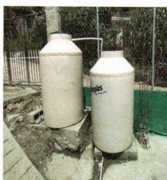
Foto 7: Sustitución de depósito de agua de 2500 LT: (Por estar a luz directa al sol, depósitos de 1100 litros, no han sido suficientes al momento de la captación de agua, por lo que se prioriza la sustitución por un depósito de 2500 litros.)
