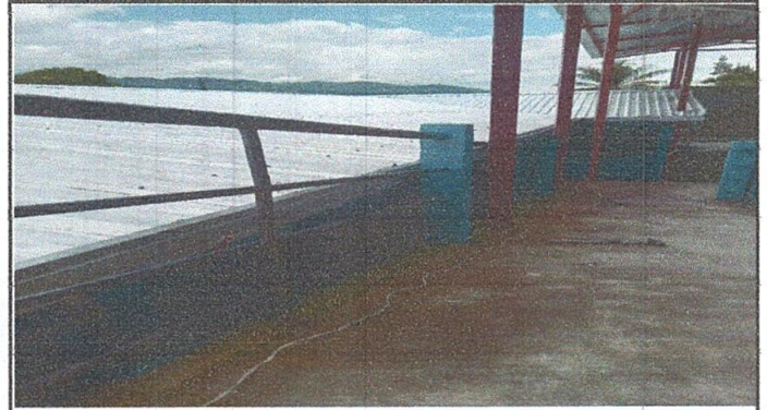
SUSTITUCIÓN DE CANALETAS
