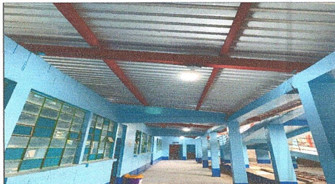
REPARACION DE SISTEMA ELECTRICO
