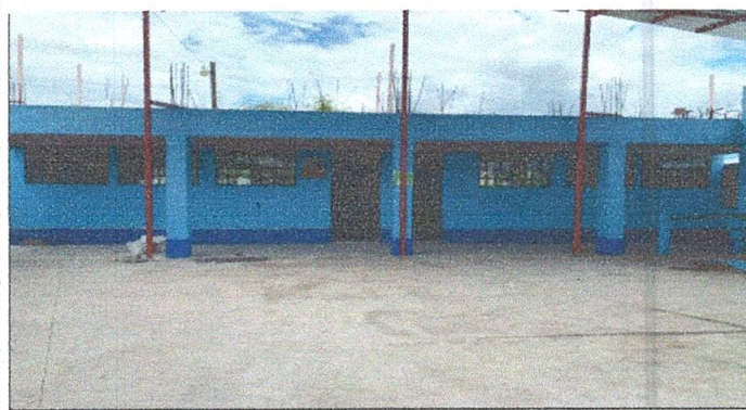
PINTURA EN MUROS EXTERIORES E INTERIORES
