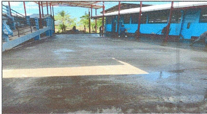
REPARACION DE PISO DE TORTA DE CONCRETO
