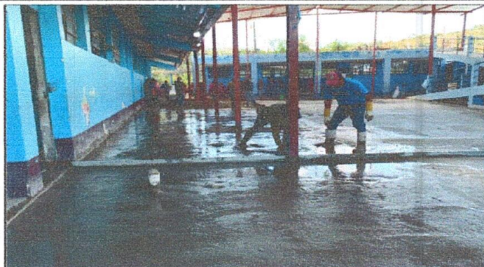
REPARACION DE PISO DE TORTA DE CONCRETO
