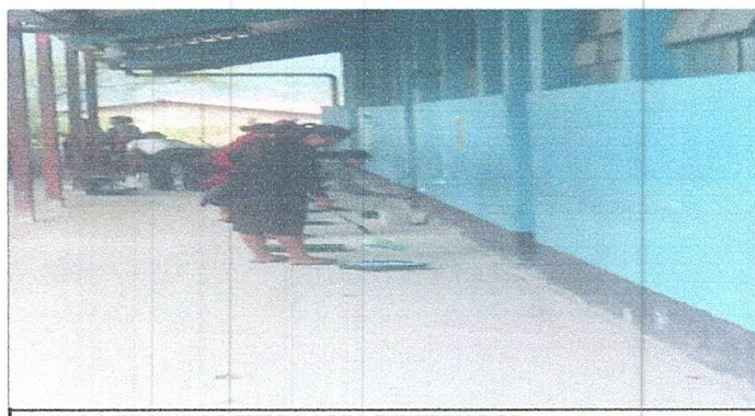
PINTURA EN MUROS EXTERIORES E INTERIORES
