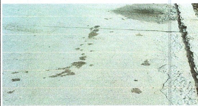
Foto 1: SUSTITUCIÓN DE PISO
