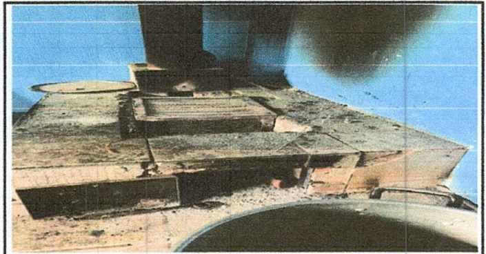
Foto 6: Sustitución azulejo en mal estado
