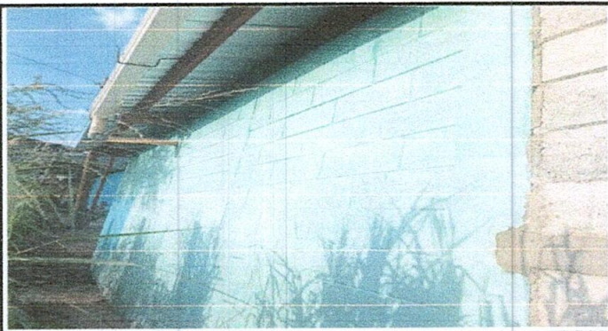
Foto 6: SUSTITUCIÓN DE PINTURA
