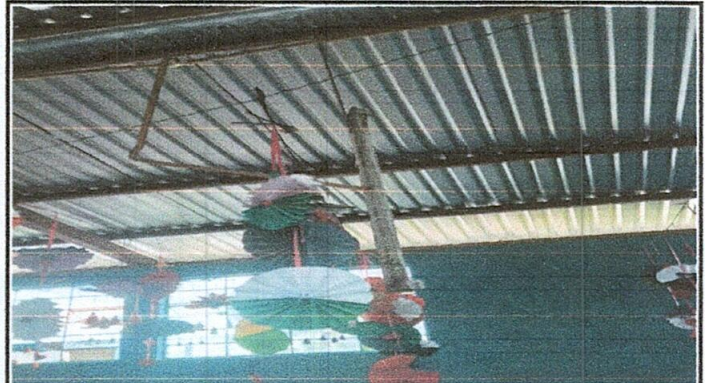
Foto 2: SUSTITUCIÓN DE SISTEMA ELECTRICO
