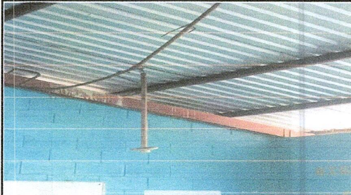
Foto 1: REPARACIÓN DE SISTEMA ELECTRICO
