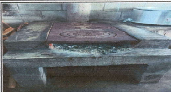
Foto 2: Sustitución de estufa rural (completa) incluye chimenea y plancha de meta
