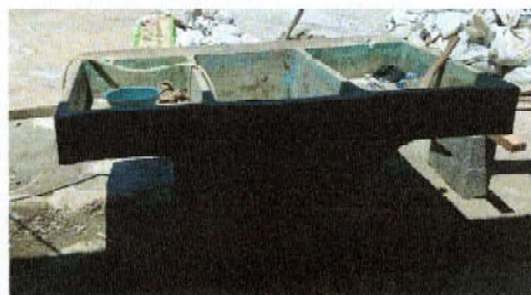
Foto 6: sustitución de pila por lavatrastes
