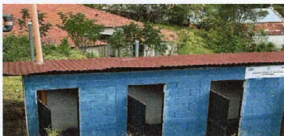
Foto 5: Sustitución de lámina, por lámina troquelada aluzinc calibre 26
