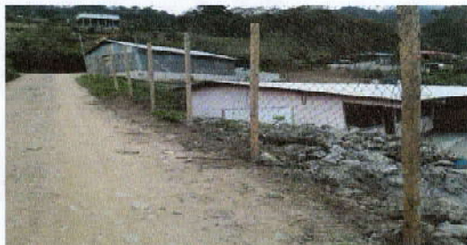
Foto1: Reparación de tubo hg y malla galvanizada
