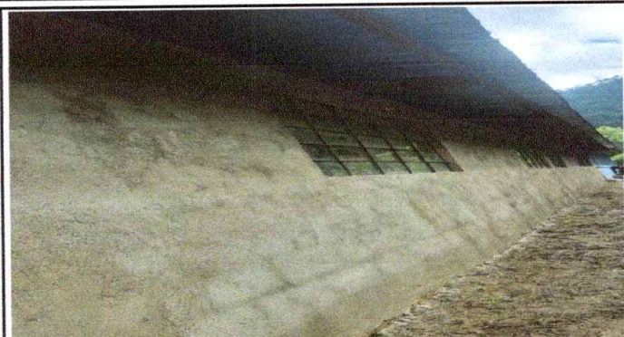
sustitucion de paredes exteriores finalizadas
