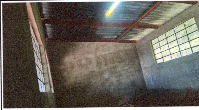
sustitucion de paredes interiores finalizadas
