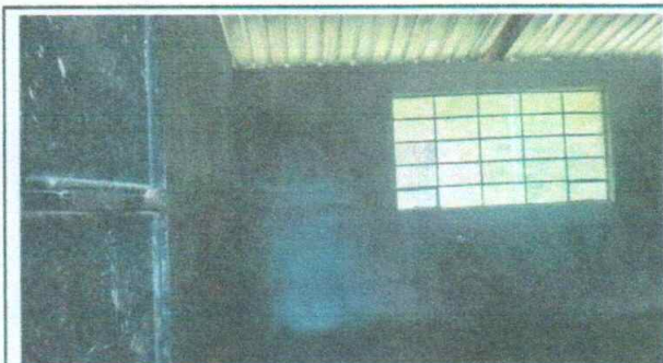
sustitución paredes interiores finalizadas
