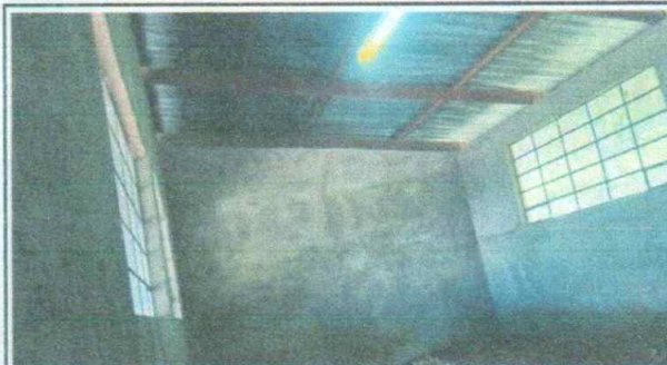
sustitucion de paredes interiores finalizadas
