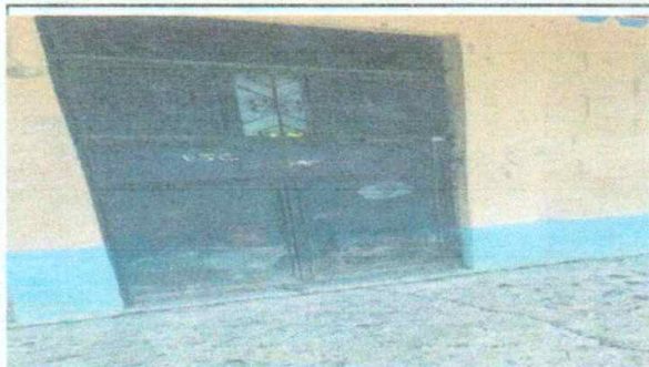
Sustitución de puerta
