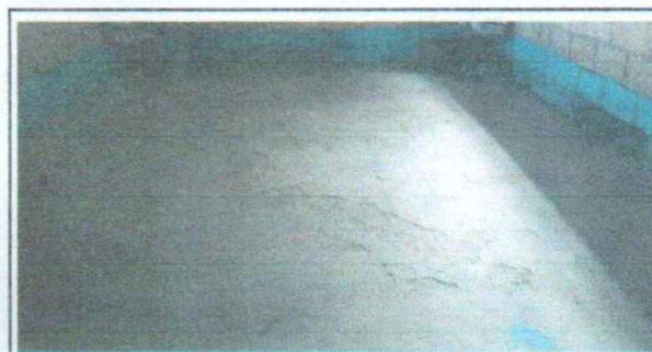
Foto 6: Sustición de piso de aulas
