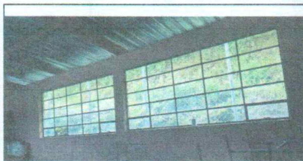
Sustitucion de pintura
