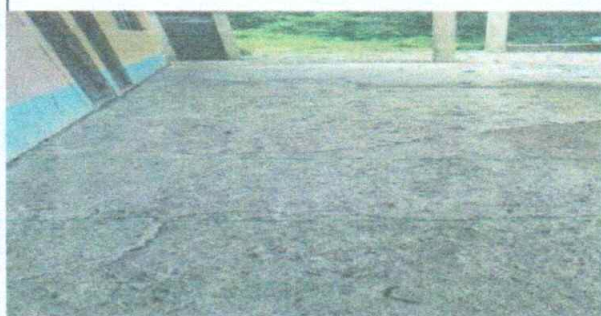
Sustitución de piso corredor
