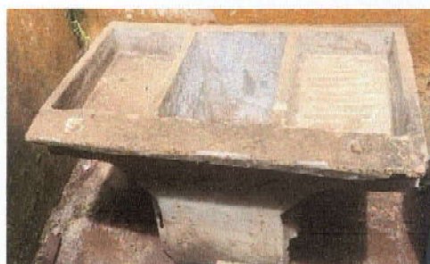
Foto 12: Sustitución de pila de cemento en mal estado
