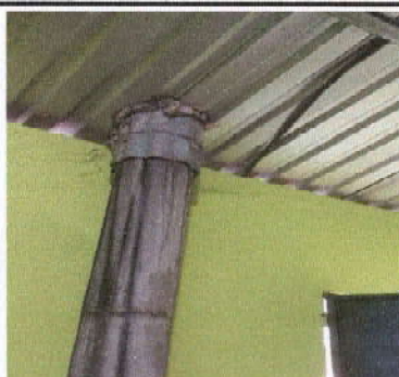
Foto 11: Reparación de chimenea en mal estado
