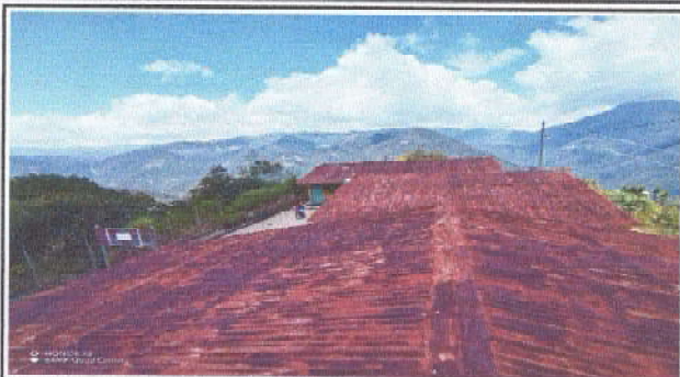
Foto1: CUBIERTA DE LAMINA
