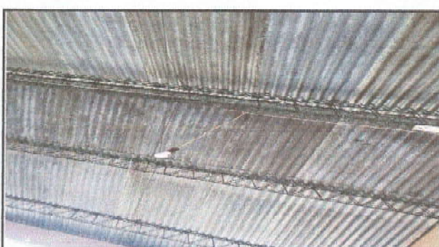
Foto 4: Sustitución de porte de soporte de láminas
