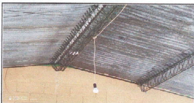
Foto 3: Sustitución de estructura de techo
