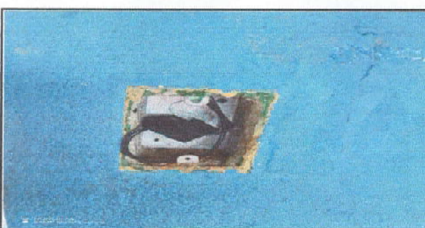
Foto 6: Sustitución interruptores simples
