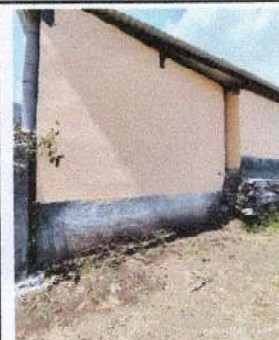
Foto 3: renglon 19, repello muro
