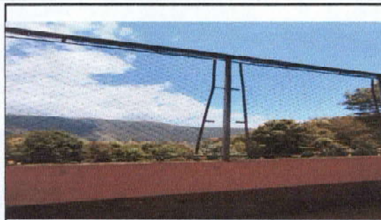
Foto 8: reparación y ampliación de circulación
