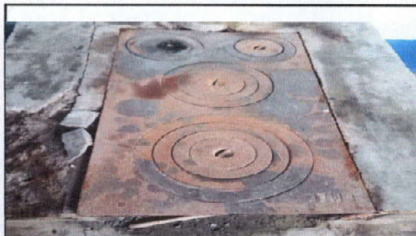
Foto 11: plancha en mal estado
