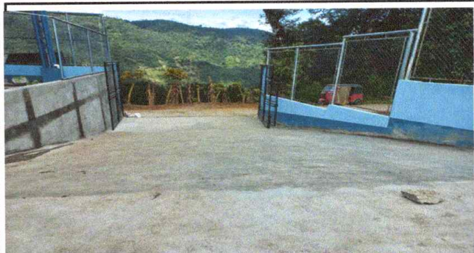
Foto 1: imagen del piso sustituido
