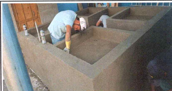
Foto 6: pila en mejoramiento
