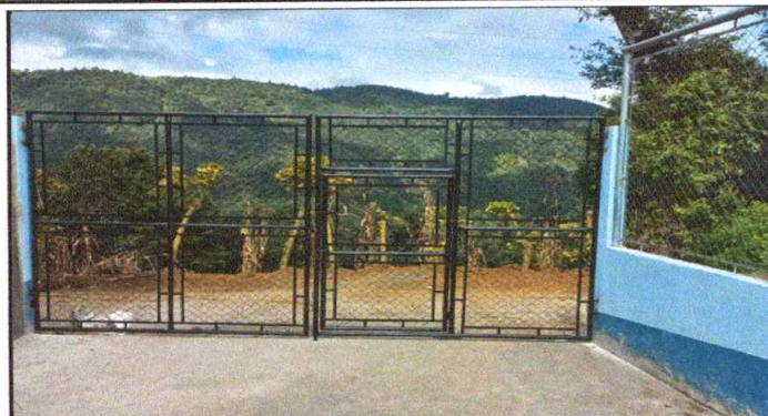
Foto 2: portón ya con mantenimiento
