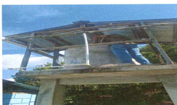
Foto 4: tubería de agua potable sustituido
