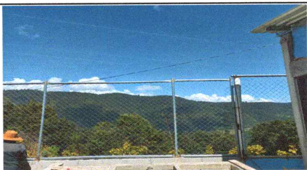
Foto 5: malla galvanizada reparada y sustituida
