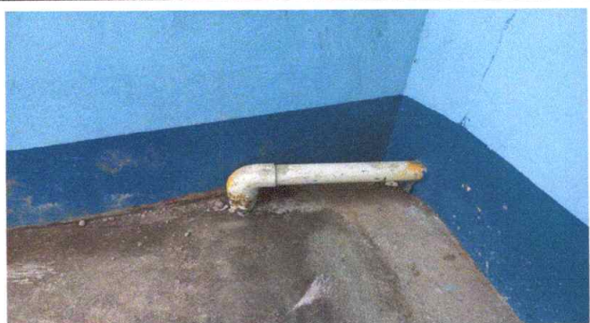
Foto 3: tubería de drenaje sustituido
