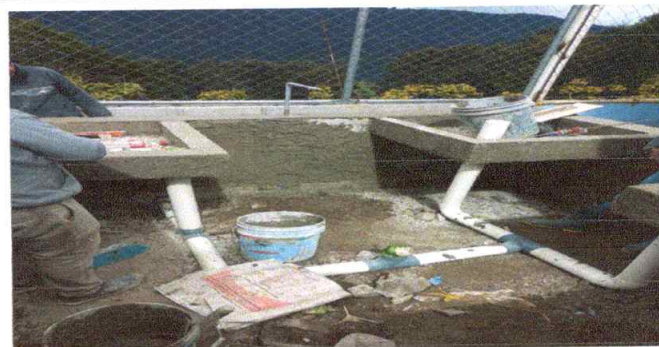
Foto 4: Sustitución de tubería línea principal agua potable
