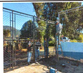
Foto 2: Mantenimiento a portones de metal (Ancho 6M2 * 2.20 de alto)
