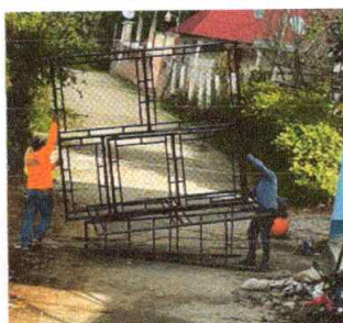
Foto 2: Mantenimiento a portones de metal (Ancho 6M2 * 2.20 de alto)
