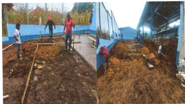
Foto1: Sustitución de piso de torta de concreto
