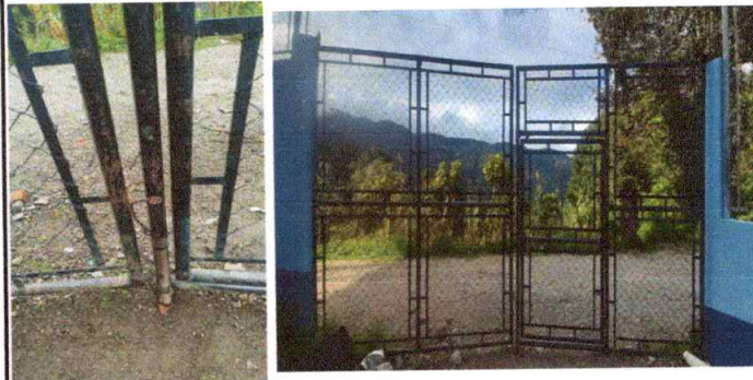
Foto 2: Mantenimiento a portones de metal (Ancho 6M2 * 2.20 de alto)
