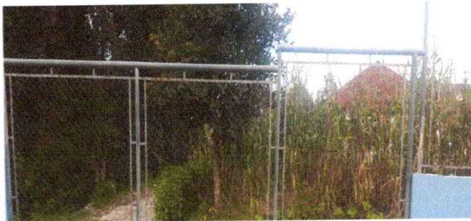
Foto 5: Reparación de tubo hg y malla galvanizada
