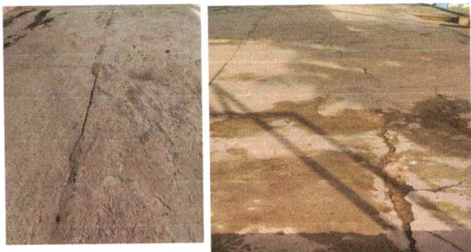
Foto1: Sustitución de piso de torta de concreto
