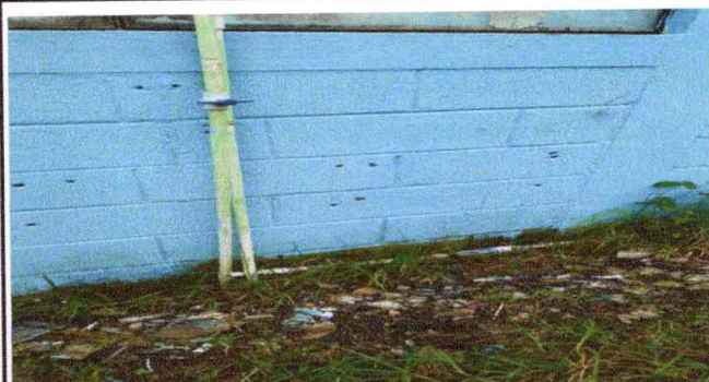
Foto 4: Sustitución de tubería línea principal agua potable
