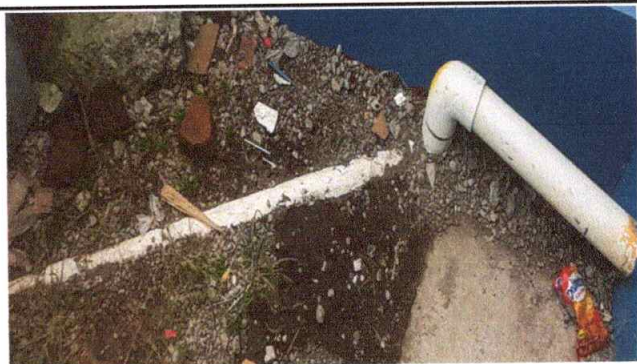
Foto 3: Sustitución de tubería PVC línea principal aguas negras
