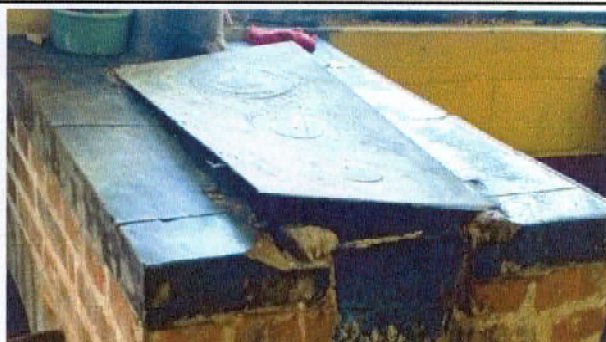
Foto 9: SUSTITUCION DE PLANCHA DE TRES HORNILLAS
