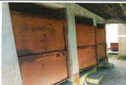
Foto 3: SUSTITUCIÓN DE PUERTAS DE SERVICIOS SANITARIOS
