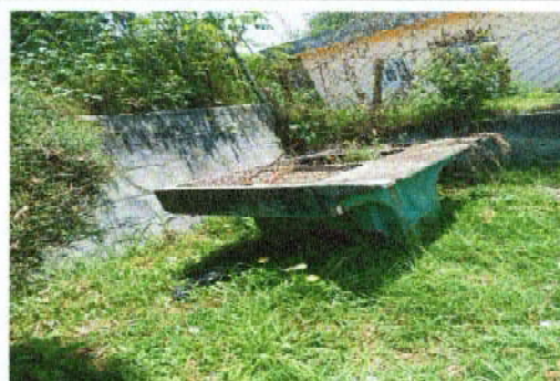
Foto 10: SUSTITUCION DE PILA DE CEMENTO DE DOS LAVADEROS
