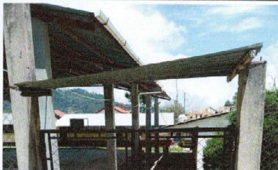
Foto1: CUBIERTA DE LAMINA
