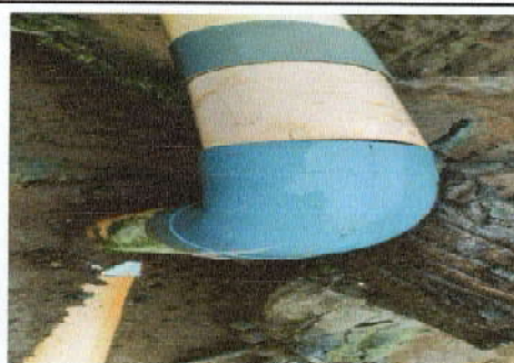
Foto 6: SUSTITUCIÓN DE TUBERIA DE DRENAJE PVC PRESIÓN 80 LINEA PRINCIPAL DE AGUAS NEGRAS COLOR BLANCO
