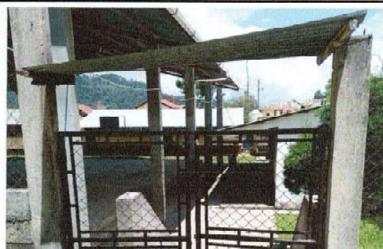
Foto 2: SUSTITUCIÓN DE ESTRUCTURA DE SOPORTE
