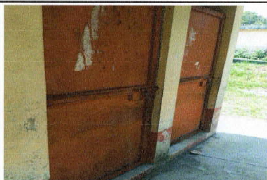
Foto 11: MANTENIMIENTO DE PUERTAS DE BAÑO Y AULAS
