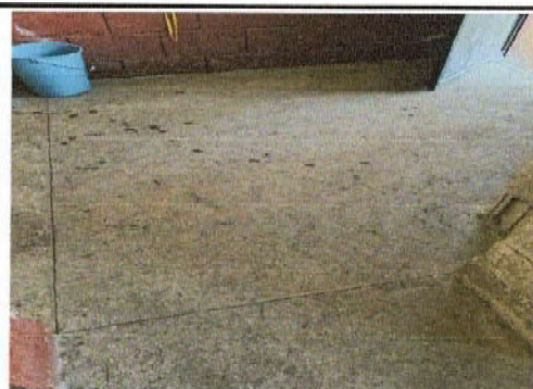
Foto 4: SUSTITUCIÓN DE PISO DE GRANITO EN COCINA
