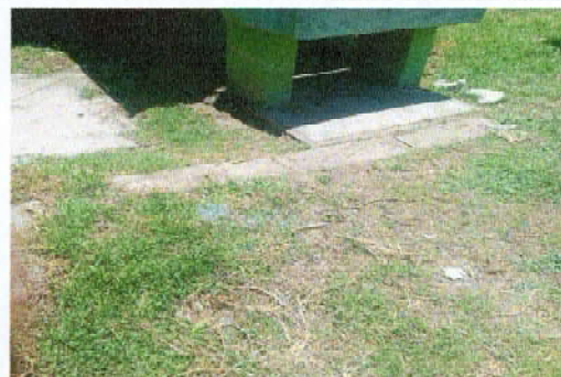
Foto 8: Piso de torta de concreto
