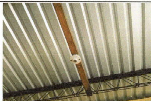
Foto 12: SUSTITUCION DE FOCOS AHORRADORES
