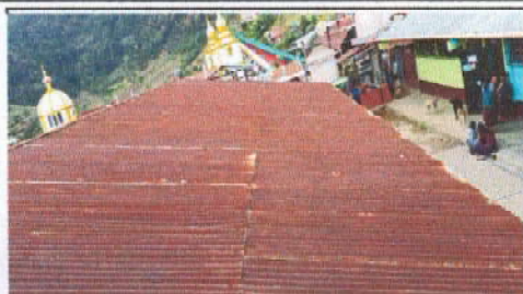
Foto1: Cambio de techo de dos salones.
