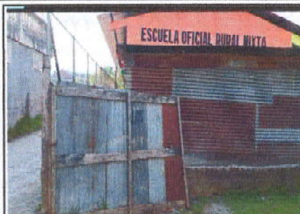
Foto 2: Sustitución de lamina por metal por porton de metal
