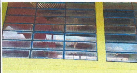
Foto 3: Sustitución de balcones
