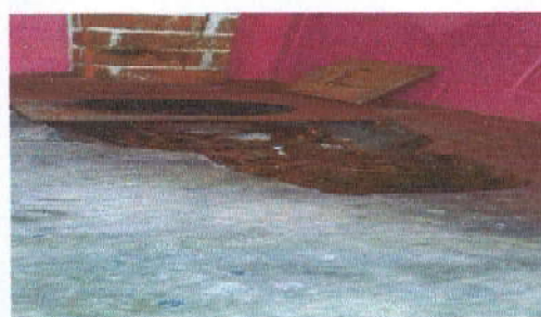
Foto 4: Reparación de cocina
