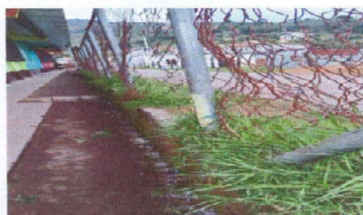
Foto 6: Circulación perimetral sustitución de maya con tubos galvanizados
