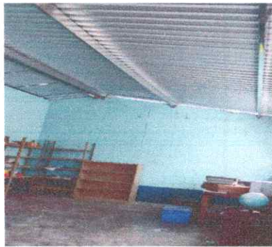
Foto 2: Terminació de costaneras
