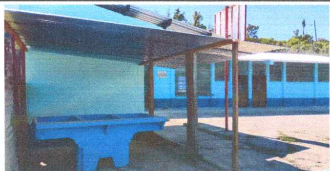
Foto 6: Pila de cemento instalada
