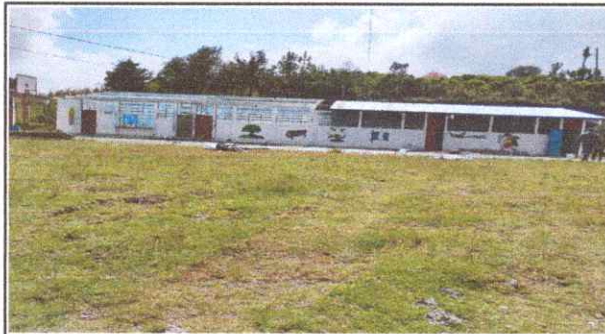
Foto 1: Colocación de techos
