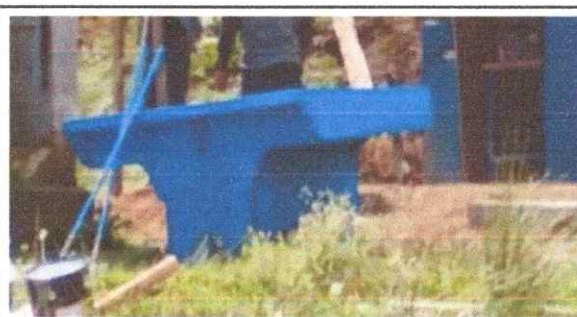
Foto 6: pila de dos lavadero nuevo
