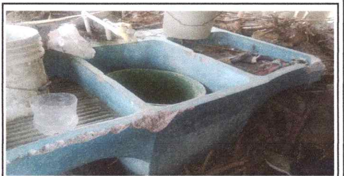
Foto 6: Pila sin valvula y quebrada
