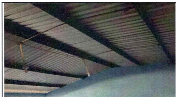
Foto 3: Cambio de lamina de aulas
