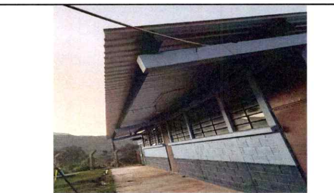
Foto 4: Cambio de lamina
