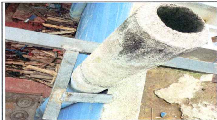
Foto 3: Cambio de lamina de cocina y costaneras
