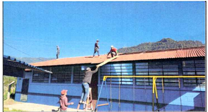
Foto 4: Cambio de lamina
