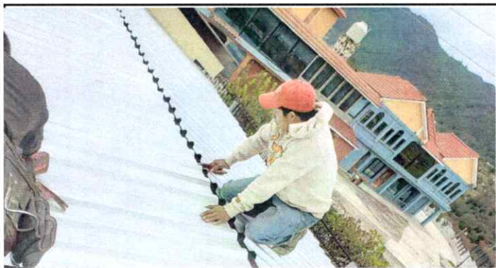
Foto 3: Cambio de lamina de cocina y costaneras
