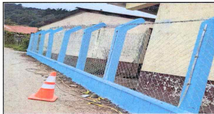
Foto 6: Pintado de muros
