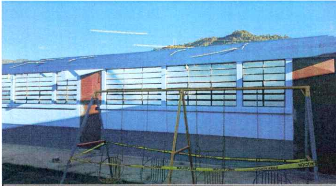
Foto 7: Cambio de lamina y pintado de costanera
