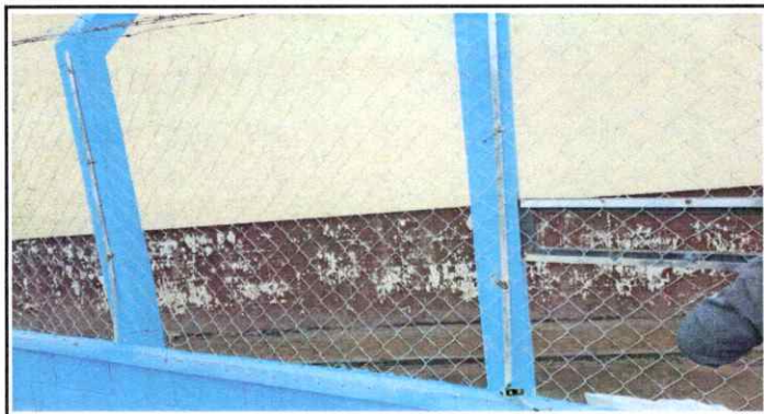
Foto 1: Cambio de maya de toda la escuela
