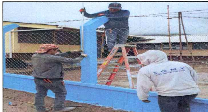
Foto 4: Cambio de pintura de circulacion
