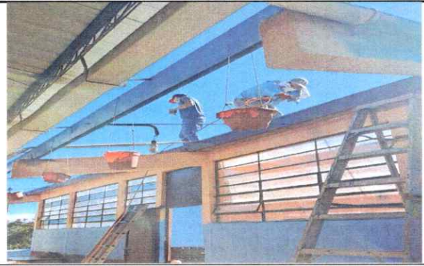
Foto 8: Cambio de lamina y pintado de costanera
