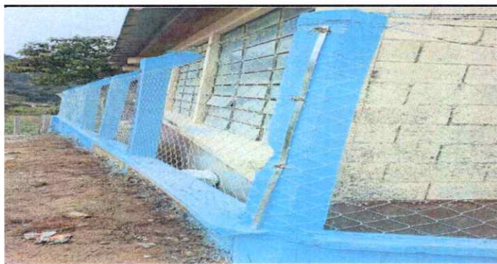
Foto 5: Pintado de muros
