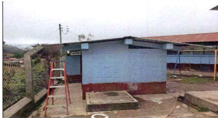
Foto 2: Cambio de lamina de baños
