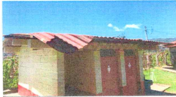
Foto 2: Cambio de laminas y costaneras en baños
