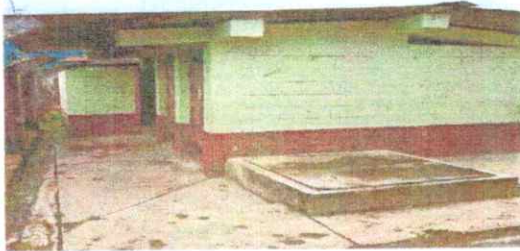
Foto 5: Cambio de costanera
