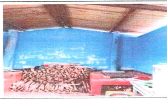
Foto 4: Cambio de costanera de madera por metal
