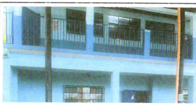
Foto 6: Implementación de hierros entorchados en barandas del segundo nivel.
