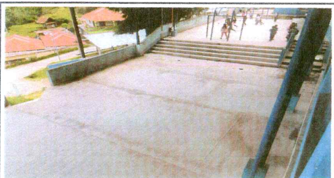
Foto 3: Imagen de la torta de cemento de cancha.
