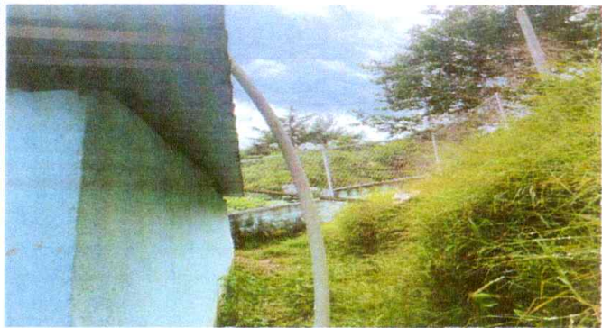
Foto 7: Tubería nueva de tinaco a baños.
