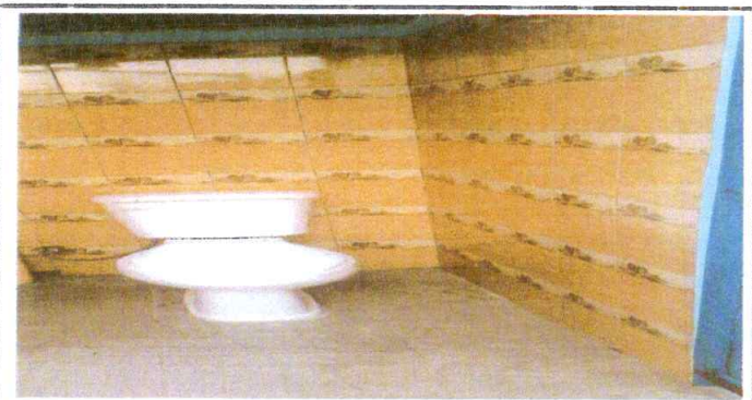
Foto 5: Baños con accesorios nuevos.
