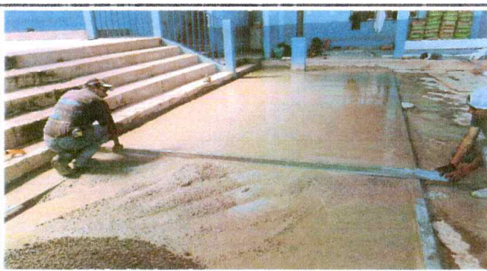
Foto 3: Sustitución de piso de torta de cemento en cancha en proceso.
