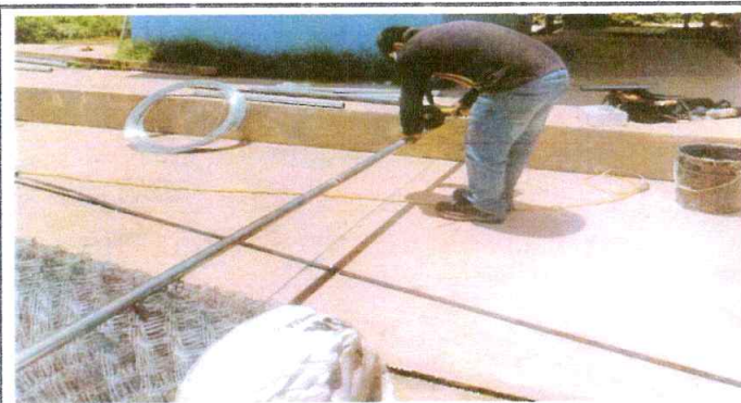
Foto 9: Mejoramiento de malla galvanizada y tubo Hg en proceso.
