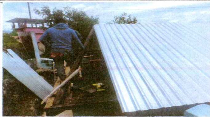
Foto1: Sustitución de láminas en proceso.
