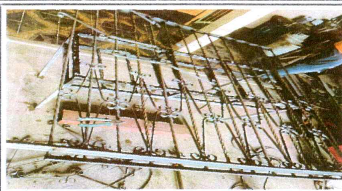
Foto 2: Mejoramiento de ventanas y balcones en proceso.
