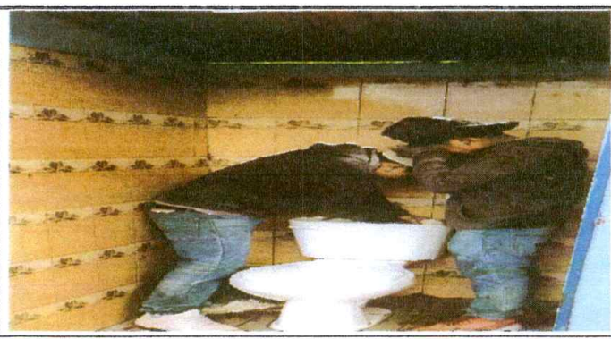
Foto 5: Sustitución de accesorios de baño en proceso.
