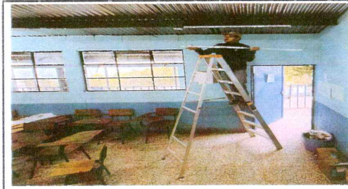
Foto 10: Sustitución de lámparas tipo LED en proceso.
