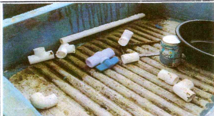
Foto 7: Mejoramiento de llave de chorro en proceso.
