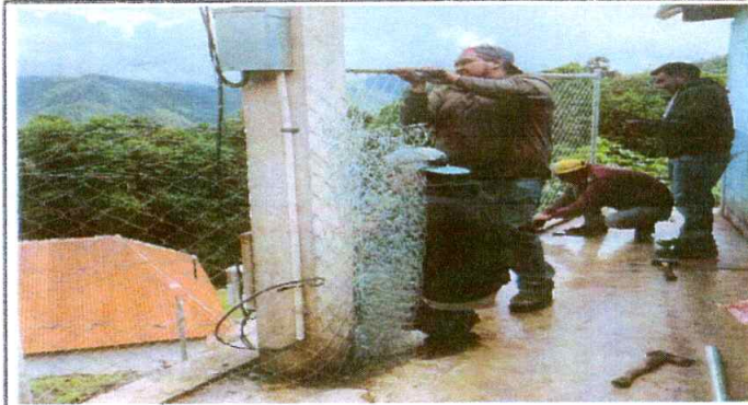
Foto 8: Mejoramiento de tubo y malla galvanizada en proceso.
