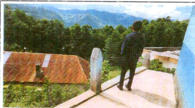
Foto 10: Sustitución de malla y tubo HG.
