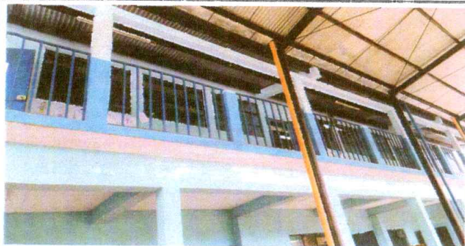
Foto 7: Mantenimiento de barandas
