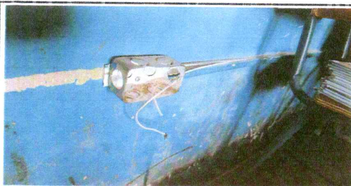
Foto 11: Sustitución de cableado eléctrico.
