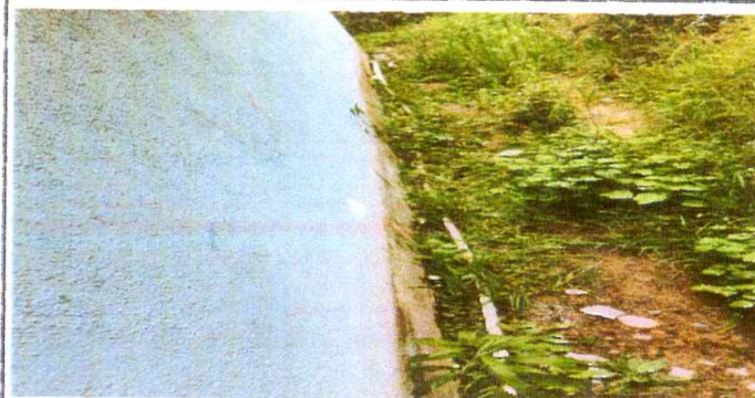
Foto 8: Sustitución de tubería en mal estado.
