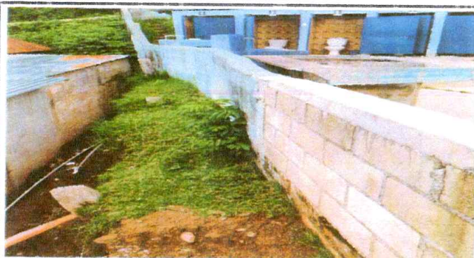
Foto 9: Mejoramiento de malla galvanizada y tubo HG.
