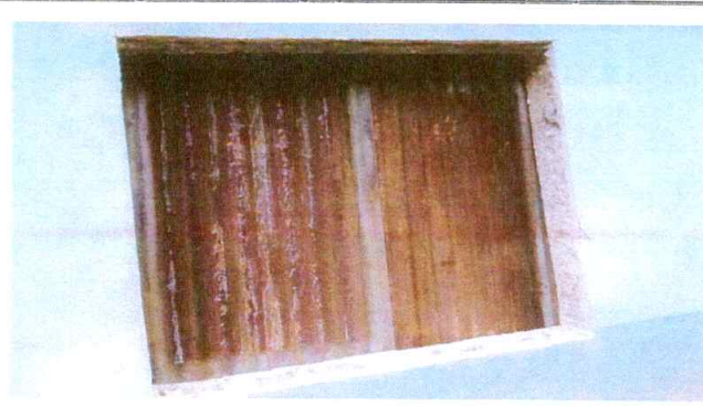
Foto 2: Mejoramiento de ventanas
