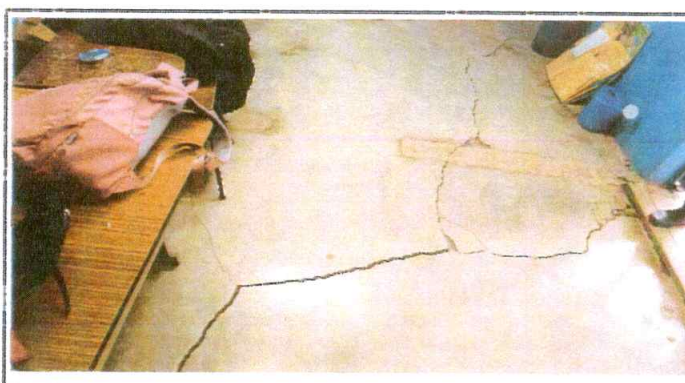
Foto 4: Sustitución de piso de torta de cemento en dirección.
