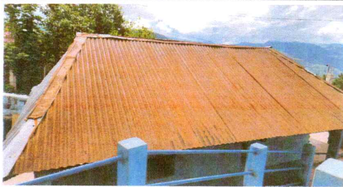
Foto 1: Sustitución de láminas.
