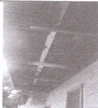
Foto1: Sustrucción de lámina por lámina troquelada en el techo de la cocina.
