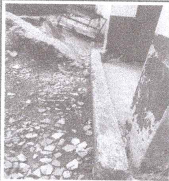
Foto3: Pintura de paredes internas y externas.
