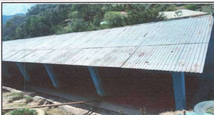
Foto 1: Sustitución de Lamina
