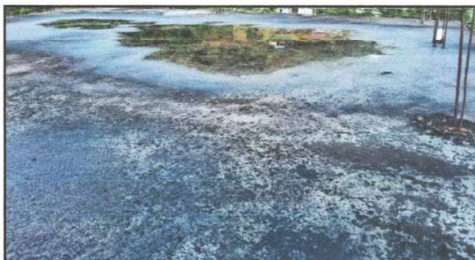
Foto 4: Impermeabilización de losa
