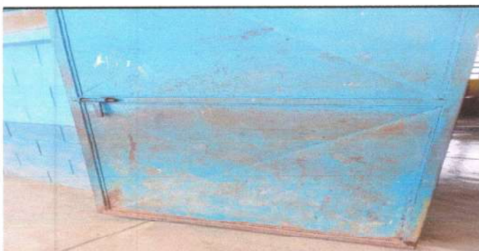
Foto 5: Mantenimiento de puerta de metal
