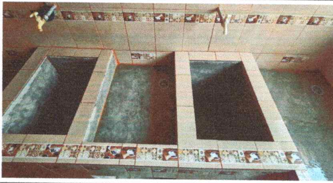
Foto1: Reparación de pila de concreto.
