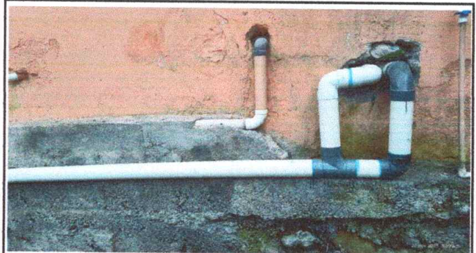
Foto 2: Sustitución de tubería PVC línea principal aguas negras.
