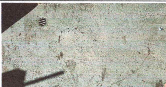
Foto 5: Sustrucción de reposaderas.
