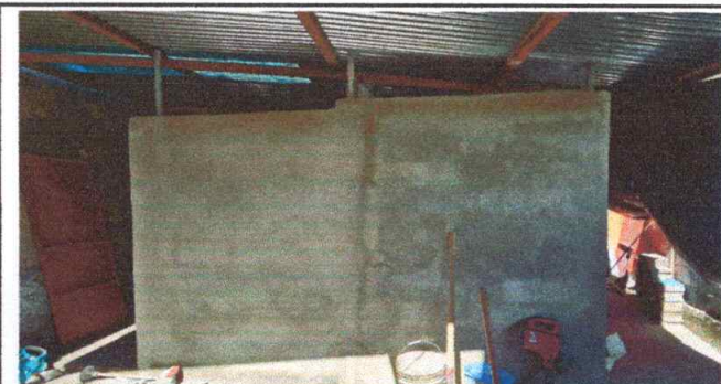
Foto 6: Repello de muro o pared.
