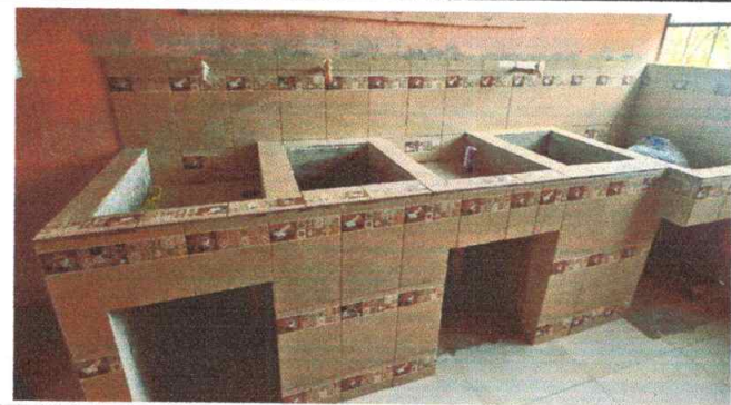
Foto 3: Sustitución de azulejo.
