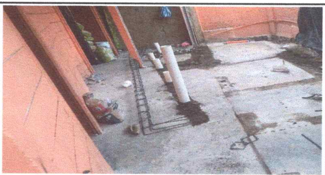
Foto 5: Sustitución de reposaderas.
