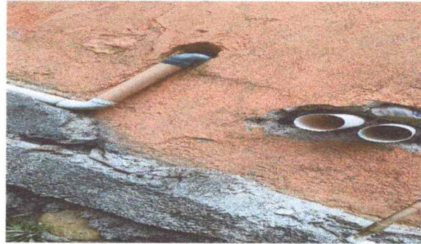
Foto 2: Sustitución de tubería PVC línea principal aguas negras.
