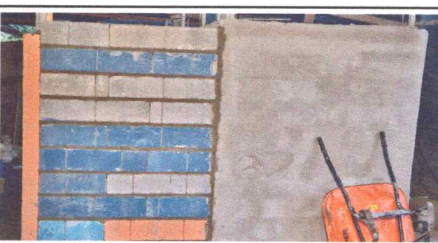
Foto 6: Repello de muro o pared.
