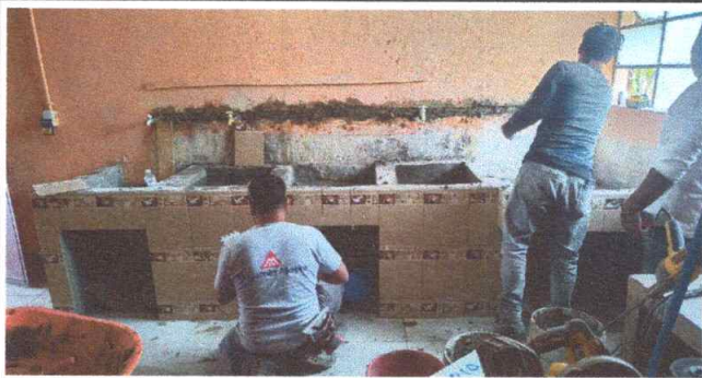
Foto 3: Sustitución de azulejo.
