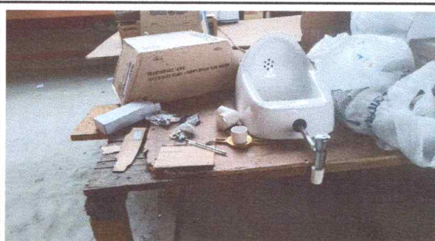
Foto 2: Sustitución de mingitorio.
