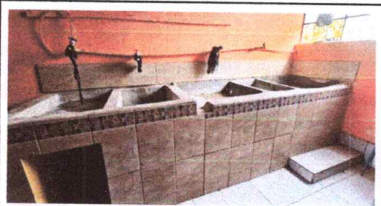
Foto 3: Sustitución de azulejo.
