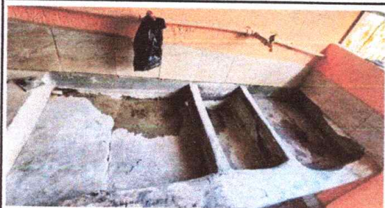
Foto 1: Reparación de pila de concreto.
