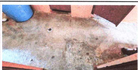
Foto 5: Sustrucción de reposaderas.
