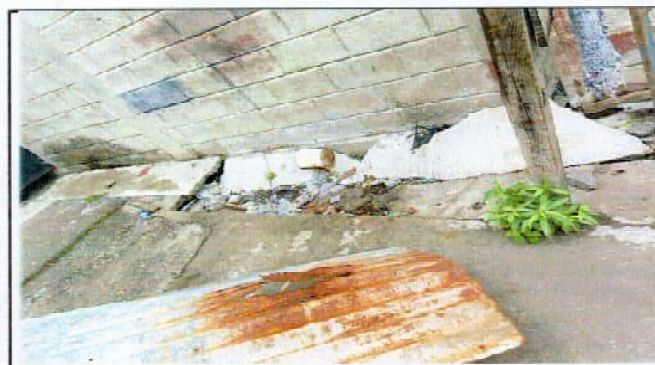
Foto 3: Reparación de torta de piso de concreto donde el acceso es difícil a los baños y peligroso para los estudiantes
