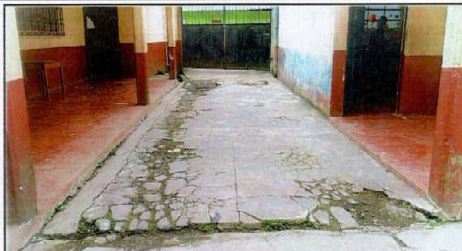
Foto 7: Reparación de torta de piso de concreto con una medida de 31 metros cuadrados, en la entrada del establecimiento
