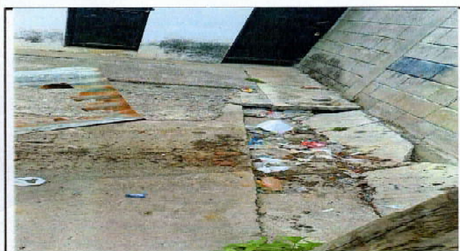
Foto 3: Reparación de torta de piso de concreto de una medida de 8 metros cuadrados ubicado cerca de la fosa septica
