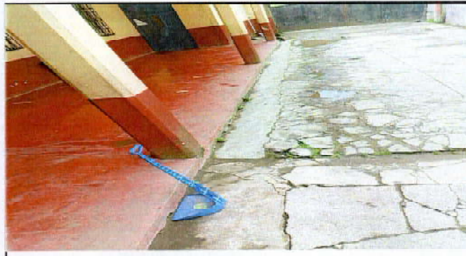
Foto 8: Reparación de cuneta que lleva el flujo de aguas residuales hacia el río
