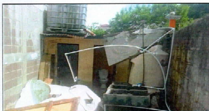
Foto 5: Sustitución por deterioro del deposito de agua lo cual conlleva riesgo por que la base sufrio daños los cuales seran reparados.
