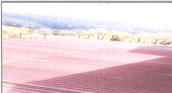
Foto 1: sustitucion de lamina, por lamina troquelada. 190 metros cuadrados. Sustitucion de capote de lamina para lamina troquelada, sustitucion de elementos de fijacion. 17 ml
