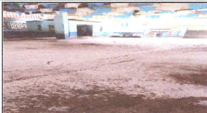
Foto 2: sustitucion de piso de torta de concreto, 135 metros cuadrados
