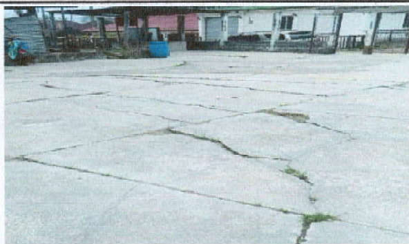
Foto 3: Sustrución de piso de concreto
