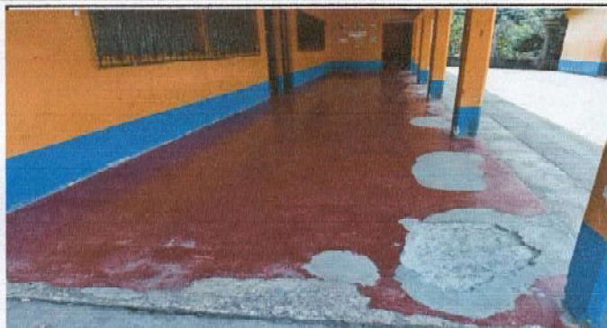
Foto 1: Sustrución de piso de granito
