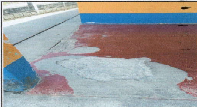
Foto 2: Sustrución de piso de granito
