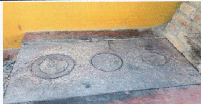
Foto 6: Plancha deteriorada y quebrada de la cocina
