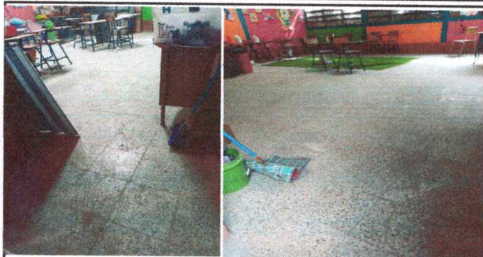
Foto1: Cambio de piso Aula 1 y Aula 2
