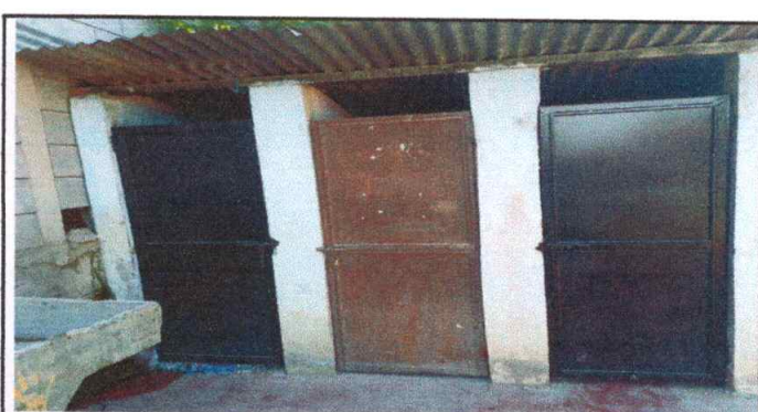
Foto 6: Cambio de 2 Puertas para baño
