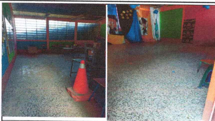
Foto 2: Cambio de piso Aula 3 y Aula 4
