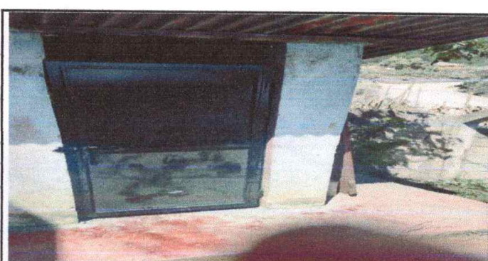
Foto 6: Cambio de 2 puertas para baño.
