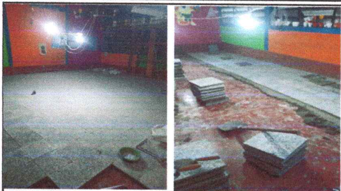
Foto1: Cambio de piso Aula 1 y Aula 2.
