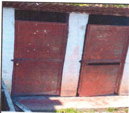
Foto 3: Cambio de dos puertas para baño.
