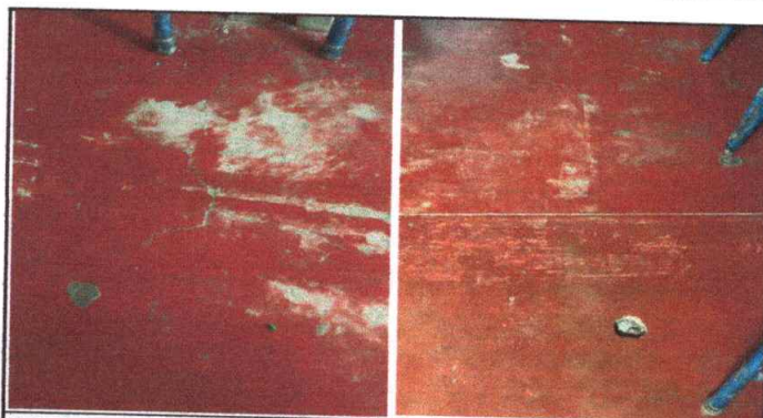
Foto 6: Cambio de piso aula 4.
