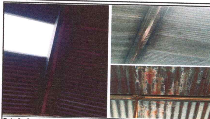
Foto 2: Cambio de laminas de techo en mal estado.
