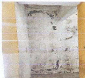
Foto 8: Repello en pared de Sanitarios.
