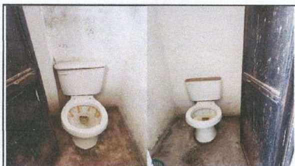
Foto 3: Sustitución de Inodoro
