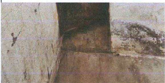
Foto 11: Sustitución de torta de cemento a piso de cemento.
