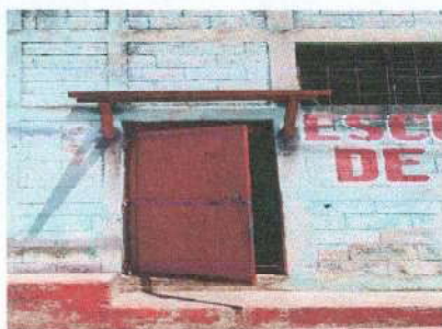
Foto 7: Mantenimiento a estructura de metal de puerta.
