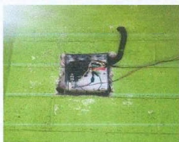
Foto13: Sustitución de pastillas y tablero para flipones
