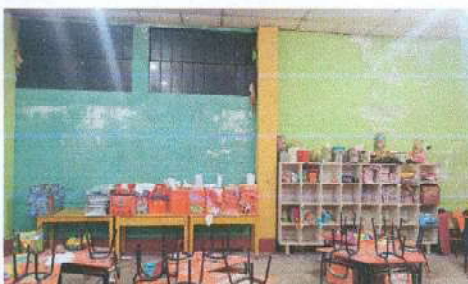
Foto15: Pintura en muros exteriores e interiores.
