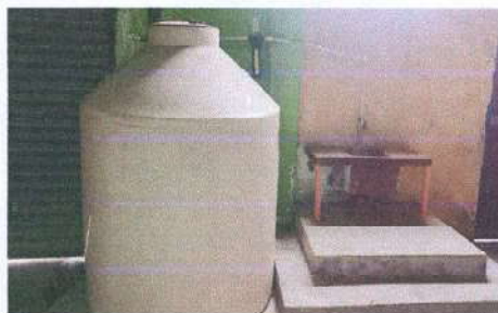
Foto 10: Instalación de tubería y bomba hidroneumática en sanitarios.
