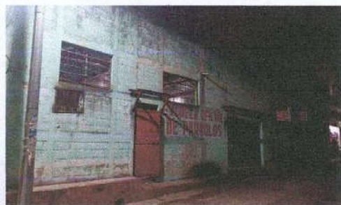
Foto15: Pintura en muros exteriores e interiores.
