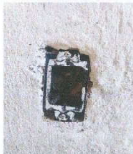
Foto 14: Sustitución de placa apagador
