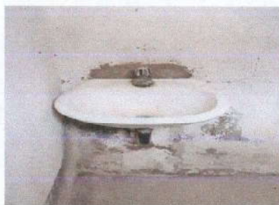
Foto 9: Sustitución de lavamanos.
