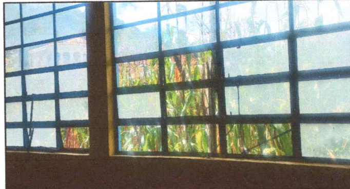
Foto 4: Ventana con vidros ya colocados .
