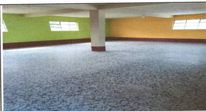
Foto 5: Evidencia de la sustitución de piso con piso de granito.
