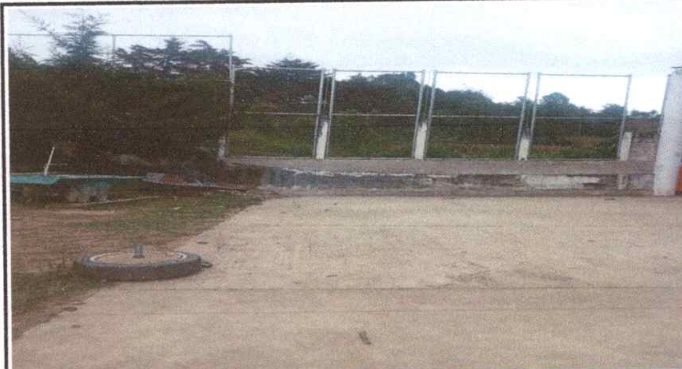
Foto 2: Evidencia de como se reparo la circulación.
