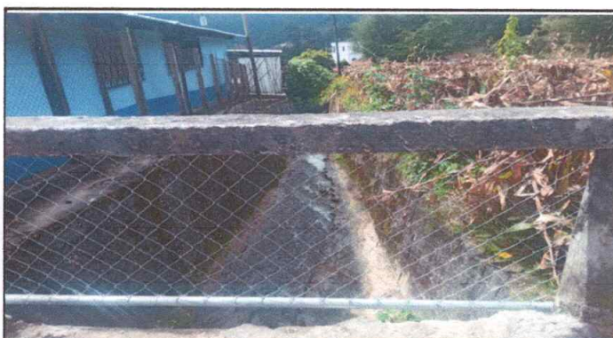
Foto 4: Repación de maya en la entrada.
