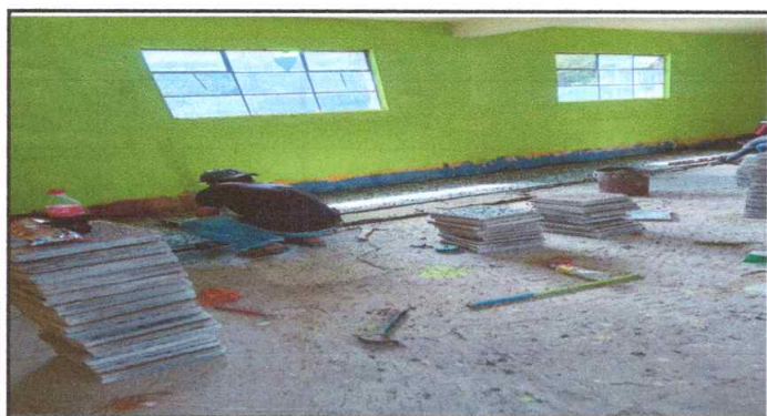
Foto 5: Estan sustituyendo el piso con piso de granito.
