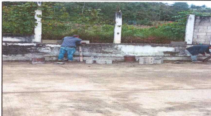
Foto 2: Estan reparando el muro y la circulación.
