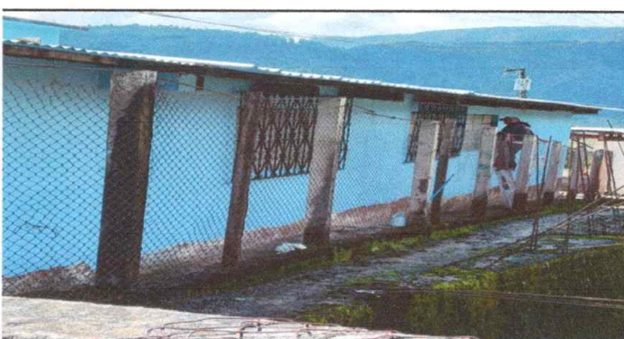
Foto 6: Evidencia de colocación de valcón en el aula.
