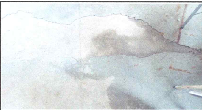
Foto 5: Sustituir el piso con piso de granito.
