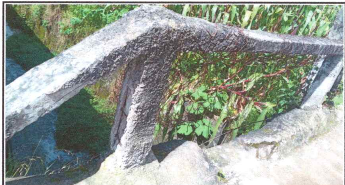
Foto 4: Reparación de maya en la entrada.
