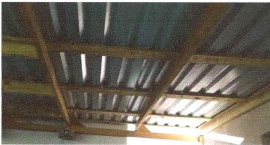
Foto 3: Sustitucion de elementos de fijación
