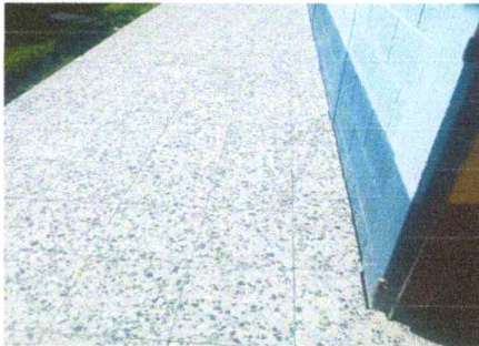
Foto1: susticion de piso de cemento por piso de granito
