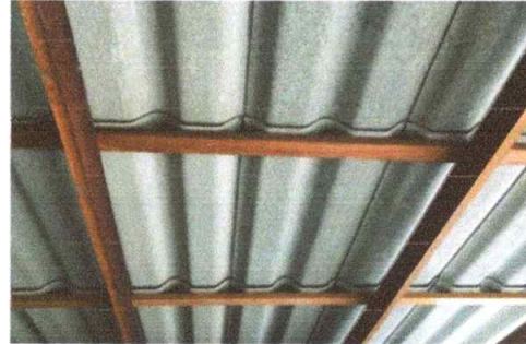
Foto 2: susticion de lamina acanalada, por lamina troquelada
