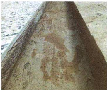
Foto 5: Reparación de cunetas de concreto
