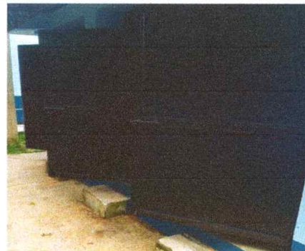
Foto 4: Sustitucion de puertas de metal
