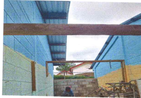
Foto 2: susticion de lamina acanalada, por lamina troquelada
