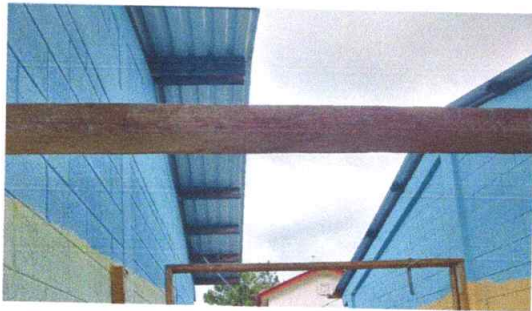
Foto 3: Sustitucion de elementos de fijación
