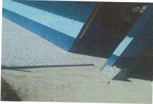
Foto1: susticion de piso de cemento por piso de granito
