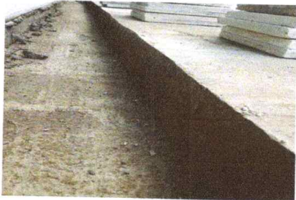
Foto 5: Reparación de cunetas de concreto
