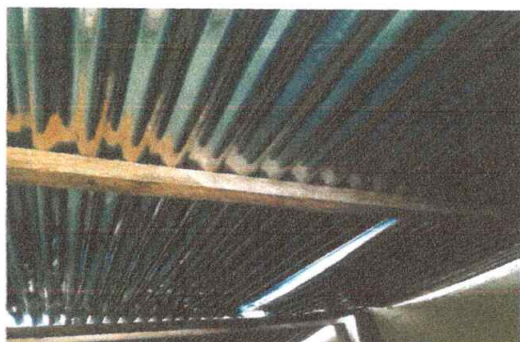
Foto 3: Sustitucion de elementos de fijación
