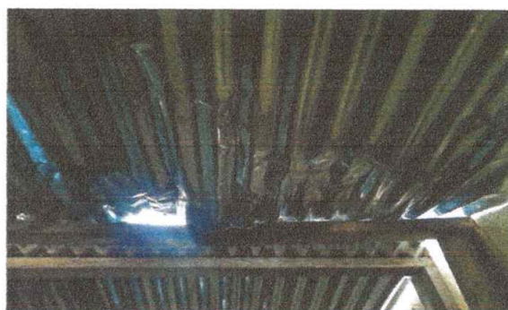
Foto 2: susticion de lamina acanalada, por lamina troquelada
