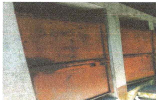
Foto 4: Sustitucion de puertas de metal
