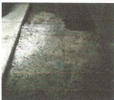
Foto 5: Reparación de cunetas de concreto
