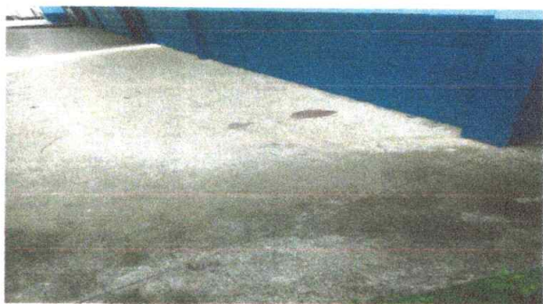
Foto1: susticion de piso de cemento por piso de granito
